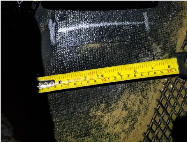
Figure 14. Fuite détectée malgré le sol gelé
