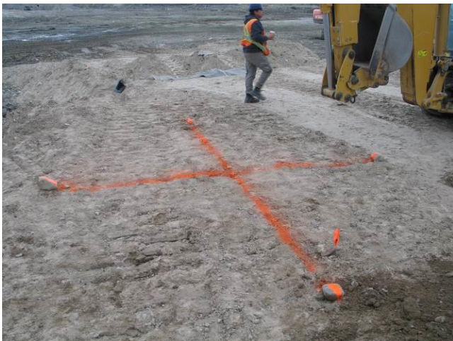
Figure 12. Localisation d'un signal de fuite
