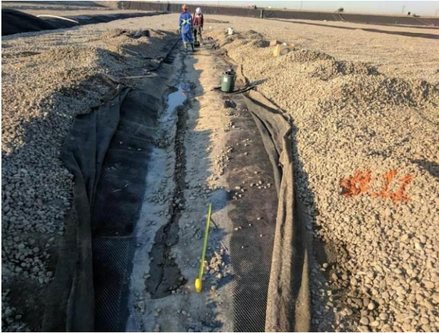
Figure 4. Déchirure de 12 m de long
