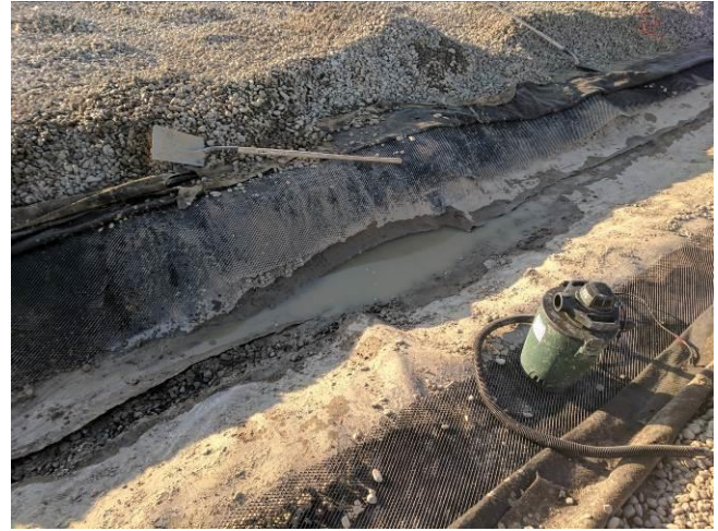
Figure 5. Creux dans l'assise à l'endroit de la déchirure
