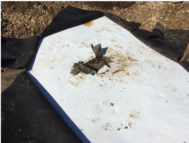
Figure 10. Pièce métallique traversant la géomembrane
