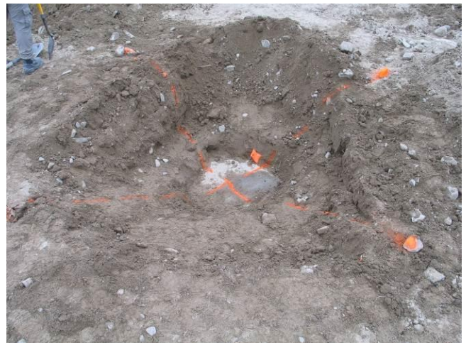
Figure 13. Excavation d'une fuite pour réparation
