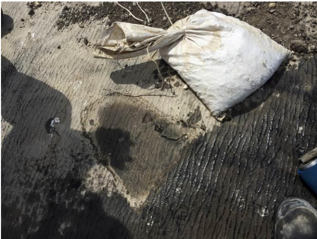
Figure 8. Sac de lest qui cachait une fuite
