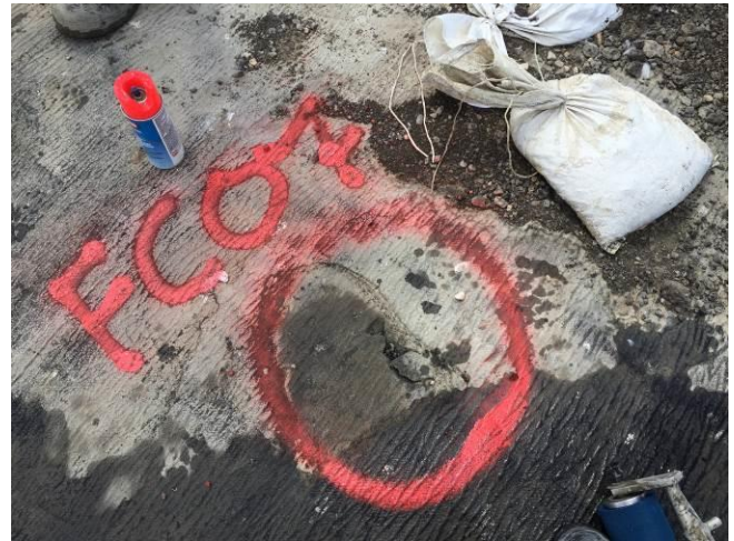
Figure 9. Marquage de peinture pour réparation
